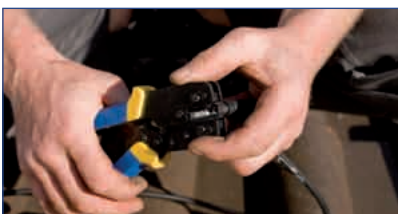
... und am Nachmittag wird die komplette Verkabelung erledigt
