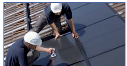
Schon nach ein paar Stunden werden die ersten PV-Module eingelegt ...
