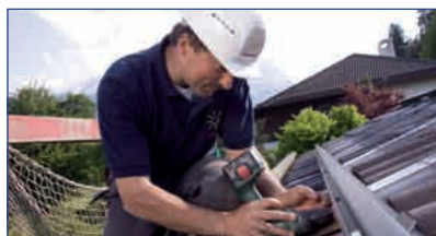
Jetzt wird das Montagesystem mit den Dachhaken fest verschraubt
