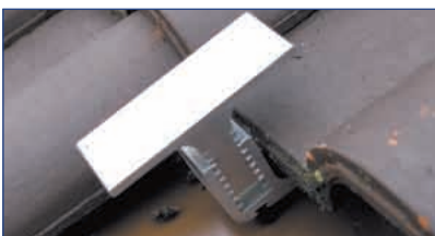
Auf ihm liegt das Montagesystem: der höhenverstellbare Dachhaken
